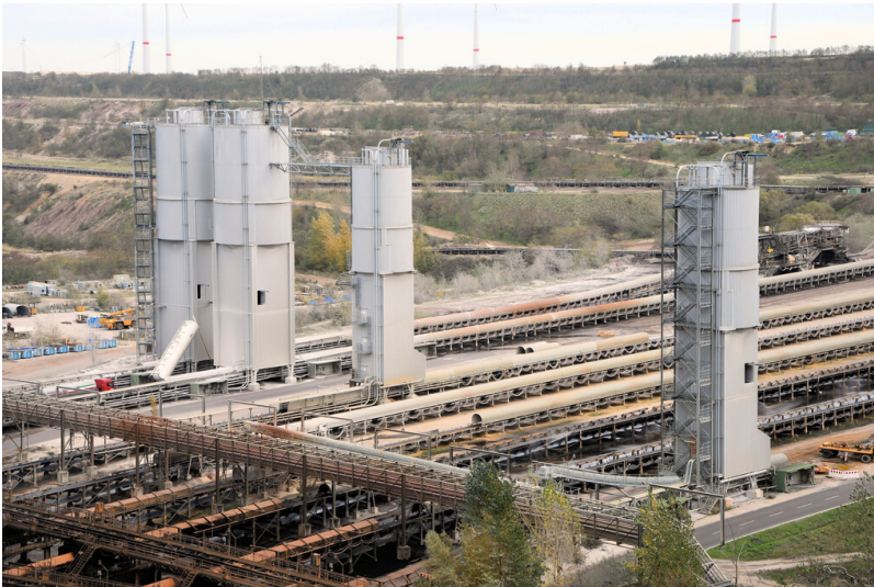
Tagebau Garzweiler: Silo- und Kompressoranlage am Bandsammelpunkt Jackerath, Ansicht von Südwesten; Foto: 03.11.2022 Fotograf/Urheber: Dr. Norbert Gilson
