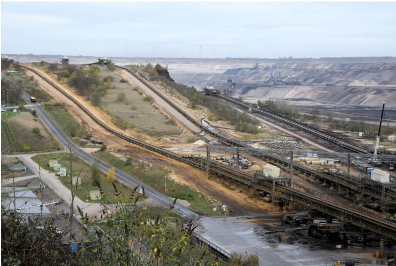
Tagebau Garzweiler: von den Gewinnungssohlen zum Bandsammelpunkt Jackerath führende Bandanlagen, Ansicht von Südwesten; Foto: 03.11.2022 Fotograf/Urheber: Dr. Norbert Gilson
