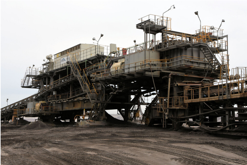
Tagebau Garzweiler: Bandantriebsstation 4 x 1.500 kW für Bandanlage B 2800; Foto: 03.11.2022 Fotograf/Urheber: Dr. Norbert Gilson
