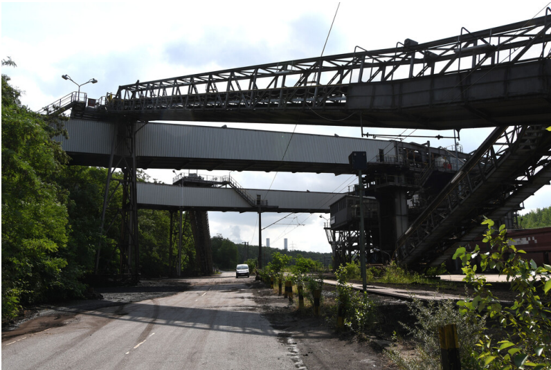
Tagebau Garzweiler: Zugbeladeanlage L80, auf V-förmiger Bandbrückenkonstruktion verlaufendes Kellerband, Ansicht von Nordwesten; Foto: 26.06.2023 Fotograf/Urheber: Dr. Norbert Gilson
