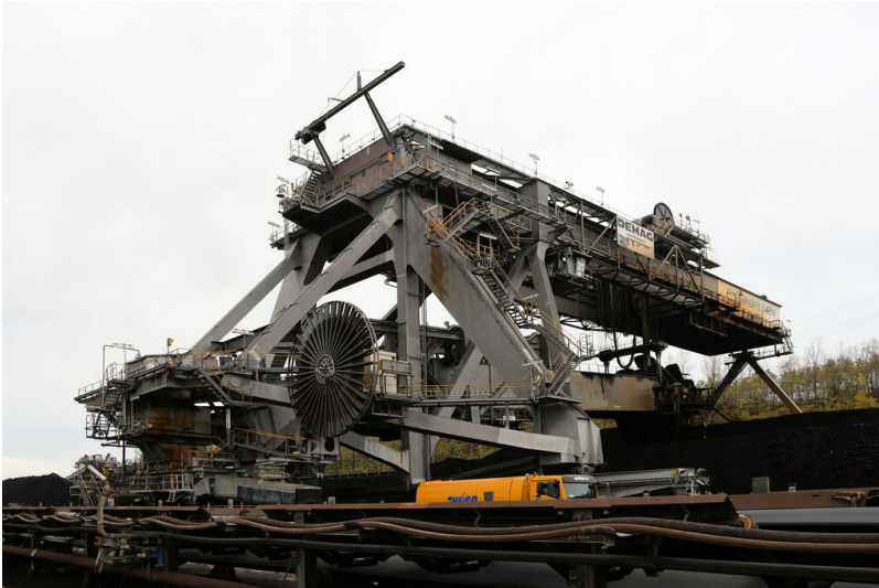
Tagebau Garzweiler: Portalaufnahmegerät 813, Bandaufgabevorrichtung; Foto: 03.11.2022 Fotograf/Urheber: Dr. Norbert Gilson
