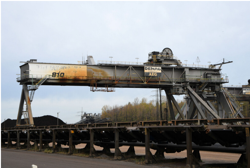
Tagebau Garzweiler: Portalaufnahmegerät 810 im Kohlebunker Garzweiler; Foto: 03.11.2022 Fotograf/Urheber: Dr. Norbert Gilson
