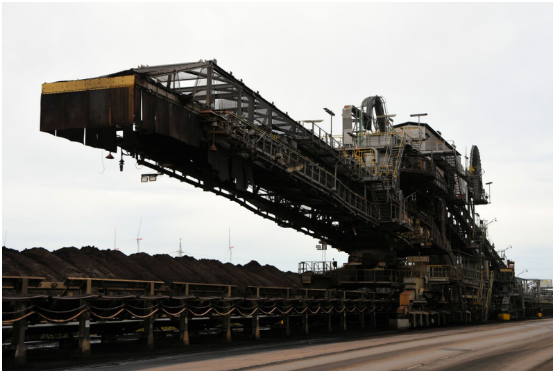
Tagebau Garzweiler: Bandschleifenwagen 991 auf Schienen im Kohlebunker Garzweiler, Ansicht von Osten; Foto: 03.11.2022 Fotograf/Urheber: Dr. Norbert Gilson
