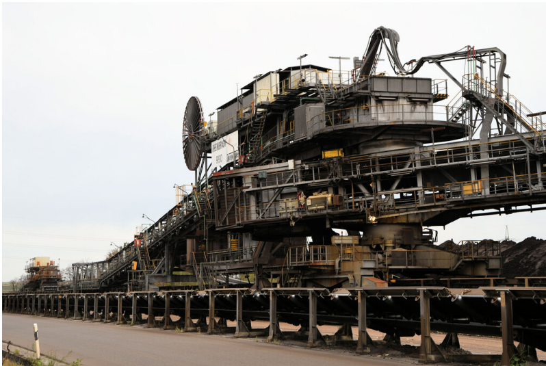
Tagebau Garzweiler: Bandaufnahme und Übergabe auf das Abwurfband bei Bandschleifenwagen 990; Foto: 03.11.2022 Fotograf/Urheber: Dr. Norbert Gilson
