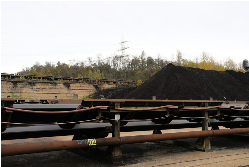
Tagebau Garzweiler: Kohlebunker Garzweiler, Kohlenhalde und stationäre Kohlebandanlage; Foto: 03.11.2022 Fotograf/Urheber: Dr. Norbert Gilson
