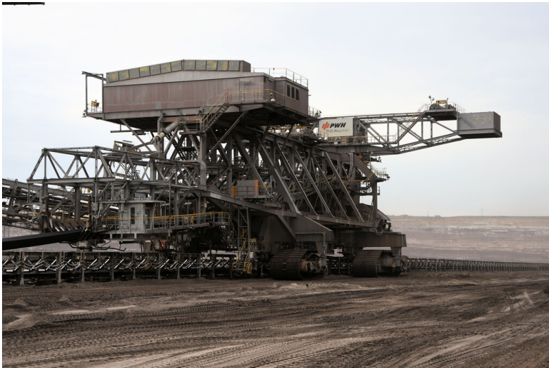
Tagebau Garzweiler: Bandschleifenwagen 951, Auflaufteil; Foto: 03.11.2022 Fotograf/Urheber: Dr. Norbert Gilson
