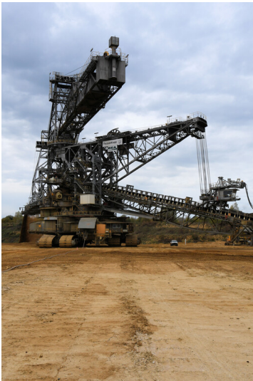
Tagebau Garzweiler: Absetzer 738; Foto: 03.11.2022 Fotograf/Urheber: Dr. Norbert Gilson
