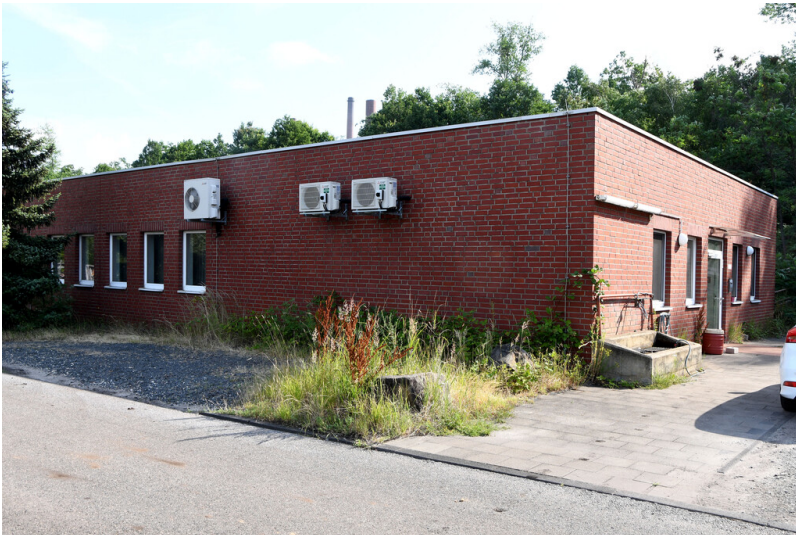
Tagebau Fortuna: Betriebsüberwachungsstelle, Ansicht von Südwesten; Foto: 26.06.2023 Fotograf/Urheber: Dr. Norbert Gilson
