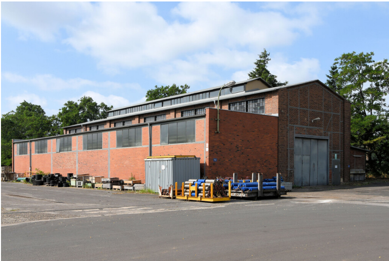
Tagebau Fortuna: ehemalige Vulkanisierhalle, Ansicht von Norden; Foto 26.06.2023 Fotograf/Urheber: Dr. Norbert Gilson
