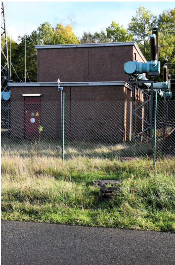
Tagebau Fortuna: 110-kV-Schaltheis der Umspannanlage, Ansicht von Westen; Foto: 09.11.2022 Fotograf/Urheber: Dr. Norbert Gilson
