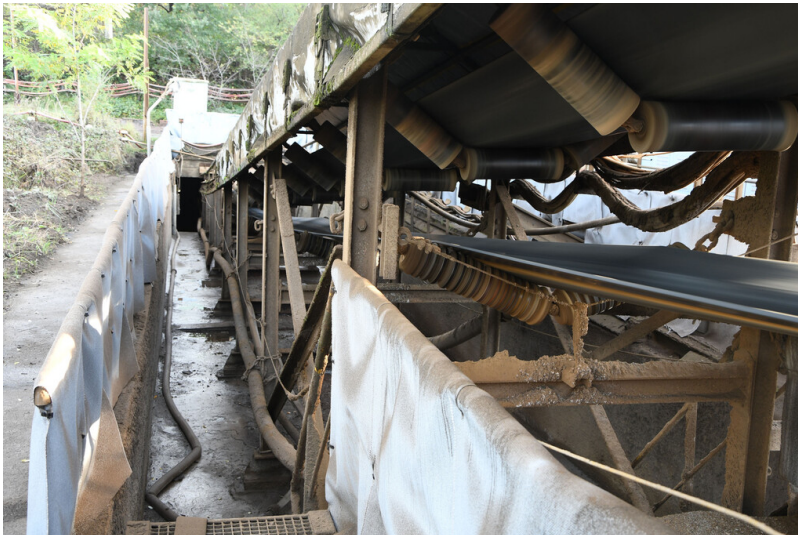
Tagebau Fortuna: Aschebandanlage aus Girlandentraggerüsten mit dreiteiligen Oberband- und zweiteiligen Unterbandgirlanden; Foto: 09.11.2022 Fotograf/Urheber: Dr. Norbert Gilson
