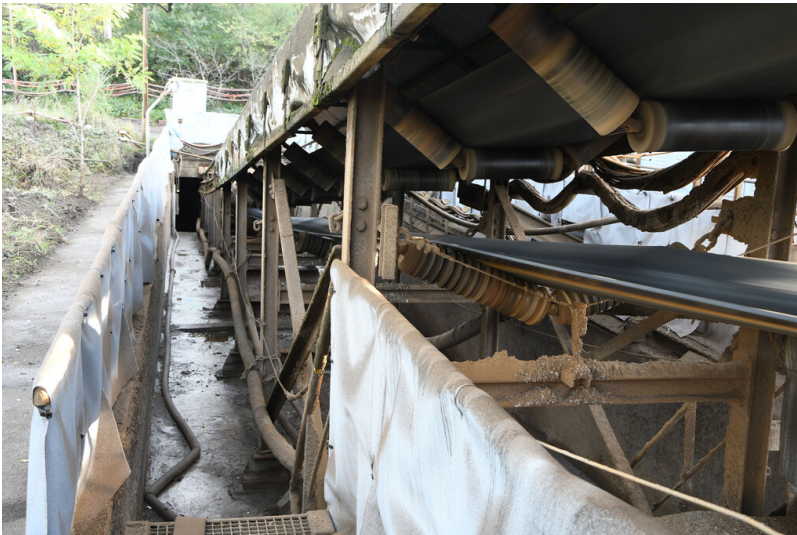
Tagebau Fortuna: Aschebandanlage aus Girlandenträgergerüsten mit dreiteiligen Oberband- und zweiteiligen Unterbandgirlanden; Foto: 09.11.2022 Fotograf/Urheber: Dr. Norbert Gilson
