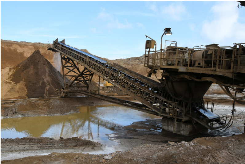
Tagebau Fortuna: Kraftwerksrückstandsdeponie Fortuna, Haldenabwurfband, Ansicht von Südwesten; Foto: 26.06.2023 Fotograf/Urheber: Dr. Norbert Gilson
