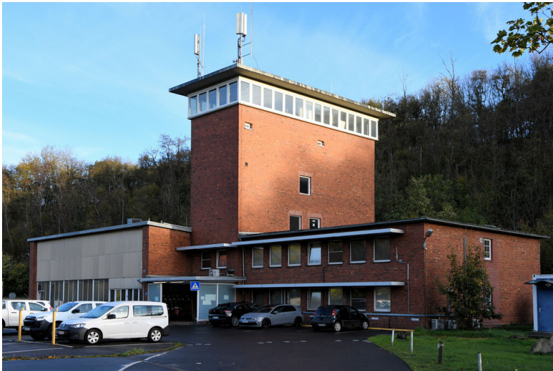
Tagebau Fortuna: Stellwerk +60-m-Sohle, Ansicht von Südwesten; Foto: 09.11.2022 Fotograf/Urheber: Dr. Norbert Gilson
