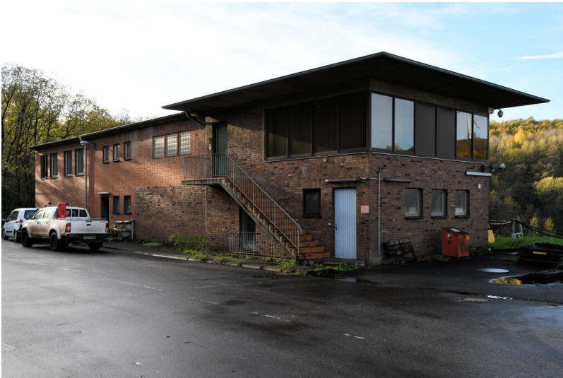
Tagebau Fortuna: Bandleitstand und Anbauten, Ansicht von Norden; Foto: 09.11.2022 Fotograf/Urheber: Dr. Norbert Gilson
