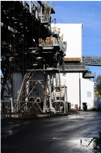
Tagebau Fortuna: Kohlezerkleinerungsanlage mit der zweisträngigen Bandzuführung, Ansicht von Süden; Foto: 09.11.2022 Fotograf/Urheber: Dr. Norbert Gilson
