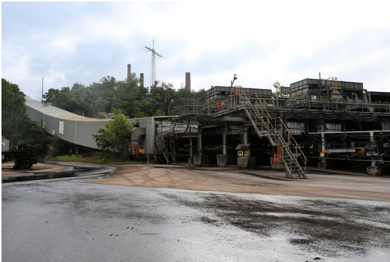
Tagebau Fortuna: Bandanlage von der Kohlezerkleinerungsanlage (KZA) zum Verteilbunker des Kraftwerks Niederaußem, Ansicht von Westen; Foto: 26.06.2023 Fotograf/Urheber: Dr. Norbert Gilson
