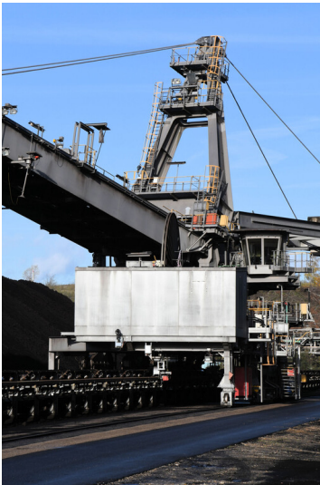
Tagebau Fortuna: Gleisfahrwerk und Schwenkwerk mit Seilstützpylon des Aufnahmegeräts 815, Ansicht von Südosten; Foto: 09.11.2022 Fotograf/Urheber: Dr. Norbert Gilson
