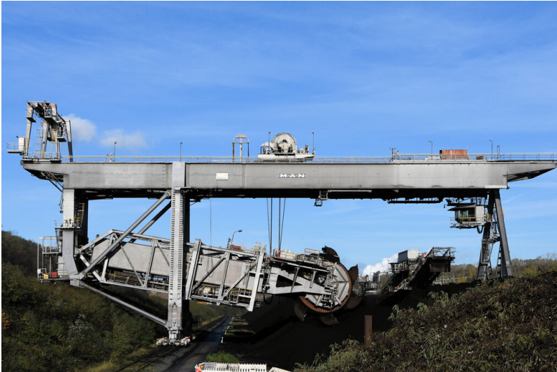
Tagebau Fortuna: Aufnahmegerät 808 im Kohlebunker Fortuna, Ansicht von Südosten; Foto: 09.11.2022 Fotograf/Urheber: Dr. Norbert Gilson
