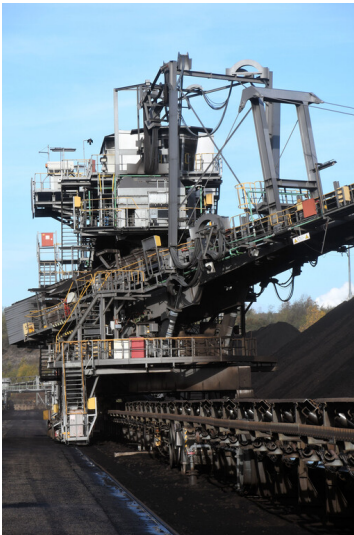
Tagebau Fortuna: Bandschleifenwagens 993, Fahrwerk und Auslegeraufhängung des Absetzerteils, Ansicht von Norden; Foto: 09.11.2022 Fotograf/Urheber: Dr. Norbert Gilson
