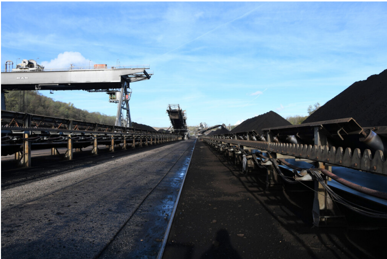
Tagebau Fortuna: Bandschleifenwagen (BSW) 986 (Mitte) im Kohlebunker Fortuna, Ansicht von Südosten; Foto: 09.11.2022 Fotograf/Urheber: Dr. Norbert Gilson
