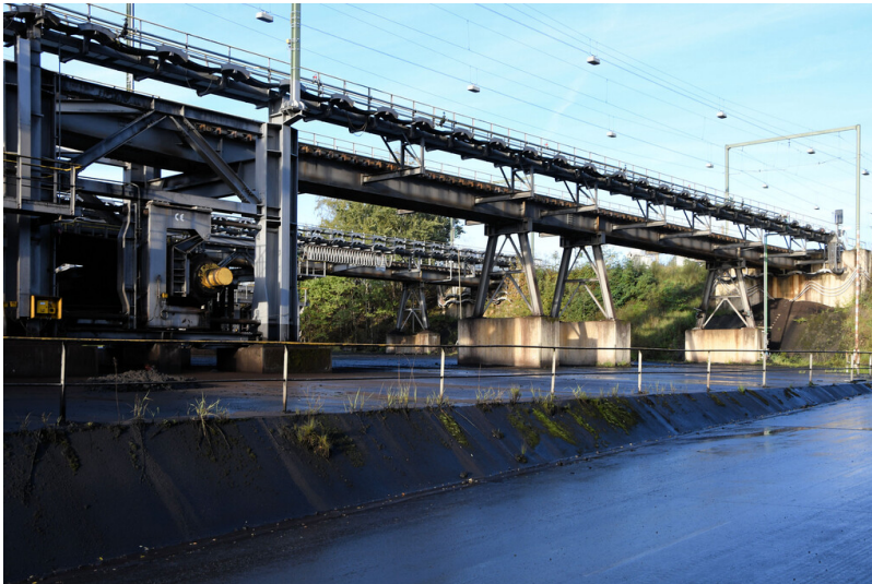
Tagebau Fortuna: Auffahrtbrücken im Norden der ZEL 1, Ansicht von Südosten; Foto: 09.11.2022 Fotograf/Urheber: Dr. Norbert Gilson
