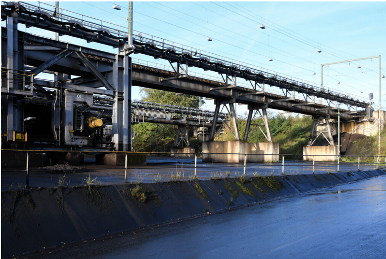
Tagebau Fortuna: Auffahrtbrücken im Norden der ZEL 1, Ansicht von Südosten; Foto: 09.11.2022 Fotograf/Urheber: Dr. Norbert Gilson
