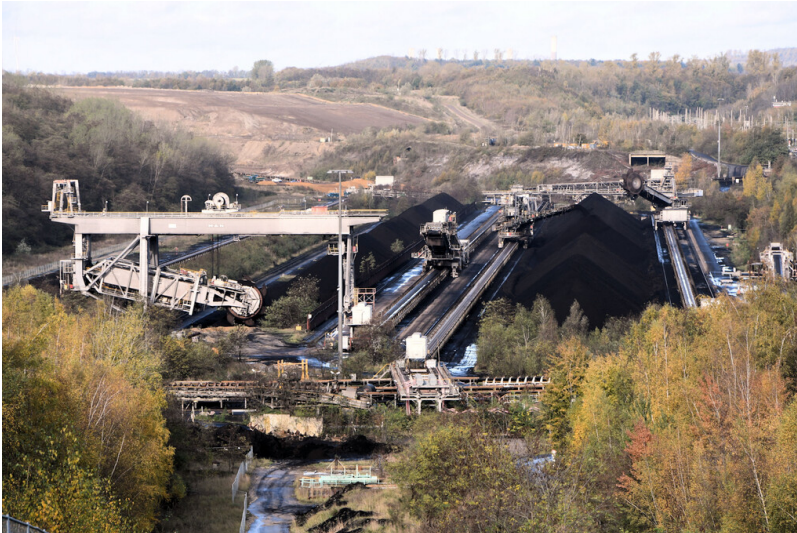
Tagebau Fortuna: Kohlebunker Fortuna mit Kohlevorratsgraben 908 (links) und Kohlenhalde 915 (rechts), Ansicht von Südosten; Foto: 09.11.2022 Fotograf/Urheber: Dr. Norbert Gilson
