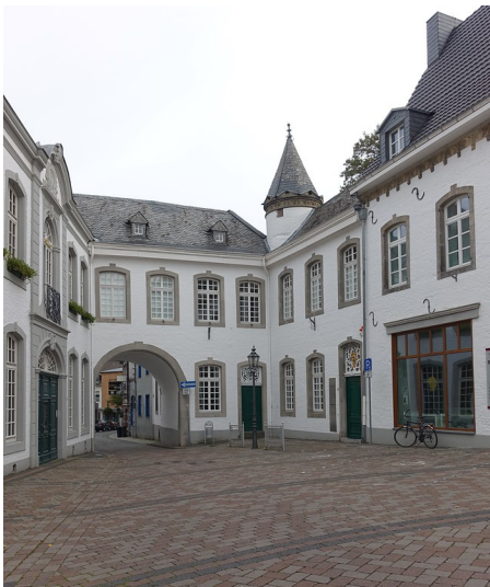
Haus Begas (2017) Fotograf/Urheber: Axel Welp
