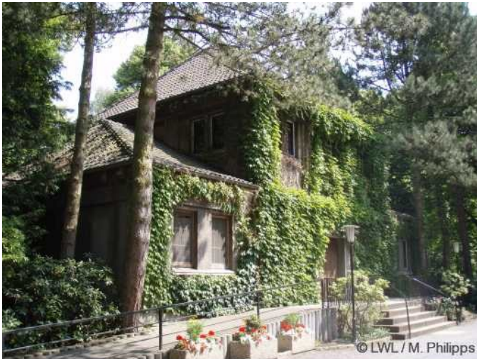
2008: Leichenhalle des Friedhofs Ickern
