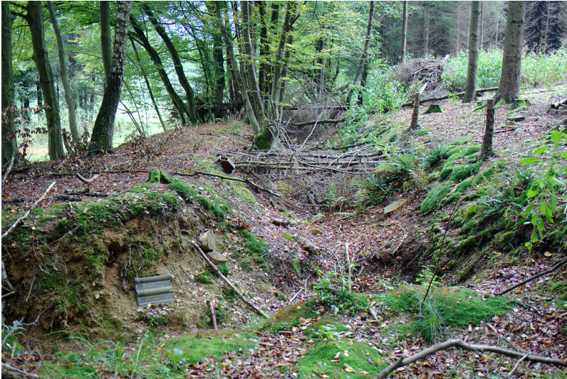
Verlandeter Obergraben der Wassermühle bei Bühlstahl (2013) Fotograf/Urheber: Schmitz, Nicole
