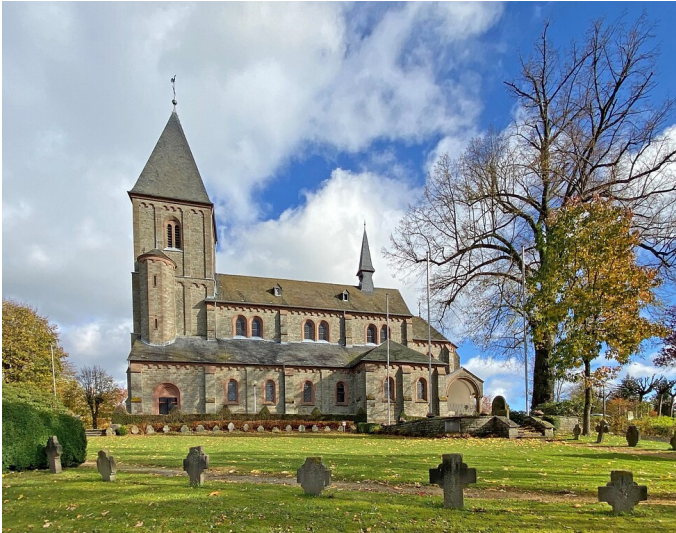
Die katholische Pfarrkirche St. Clemens in Wipperfürth-Wipperfeld (2021) Fotograf/Urheber: Dietfried Auras
