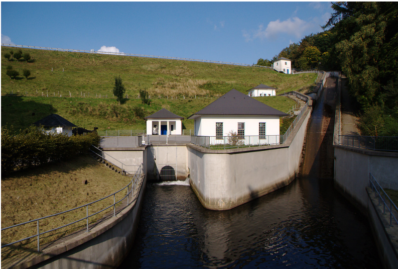
Betriebsablass der Bevertalsperre mit Betriebsgebäuden (2008) Fotograf/Urheber: Attermeyer, Adolf
