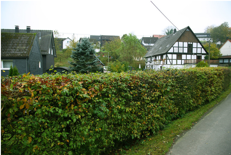
Wohngebäude in Jedinghagen (2008) Fotograf/Urheber: Giesen, Ulla Anne
