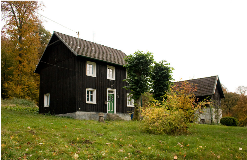
Denkmalgeschütztes Forsthaus Kümmel mit zwei geschneitelten Hauslinden (2013) Fotograf/Urheber: Schmitz, Nicole
