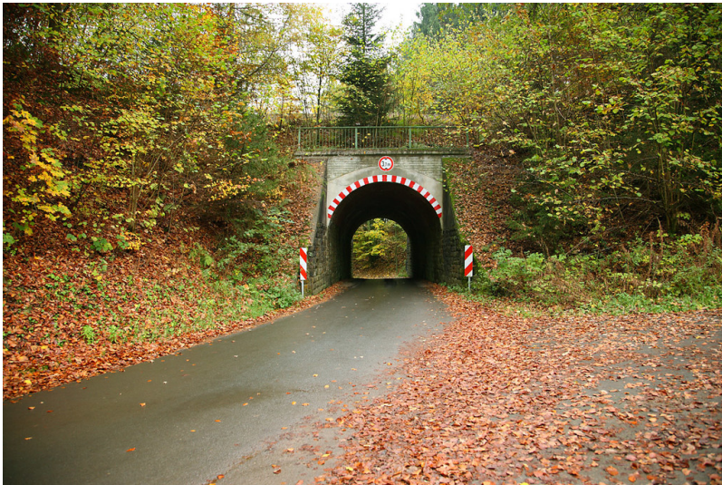
Eisenbahnunterführung der Bahnlinie Gummersbach - Marienheide - Meinerzhagen bei Schöneborn (2008) Fotograf/Urheber: Giesen, Ulla Anne
