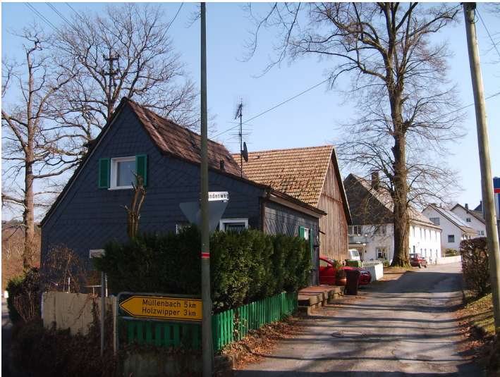
Historische Bausubstanz am Lindenweg in Linge (2009) Fotograf/Urheber: Kleefeld, Klaus-Dieter
