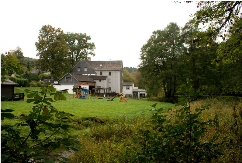
Gebäude der Scheidermühle in Nagelsbüchel (2013) Fotograf/Urheber: Schmitz, Nicole
