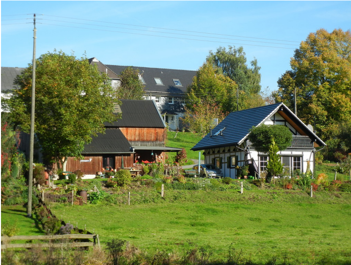
Wohnhaus mit Scheune in Niederflosbach (2013)
