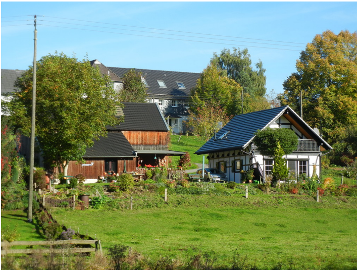
Wohnhaus mit Scheune in Niederflosbach (2013)
