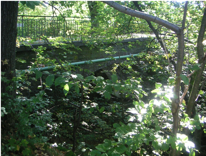
Alte Eisenbahnbrücke bei Busenberg (2007) Fotograf/Urheber: Lange, Beate
