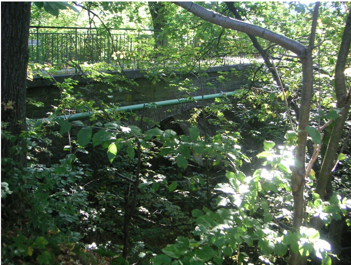
Alte Eisenbahnbrücke bei Busenberg (2007) Fotograf/Urheber: Lange, Beate
