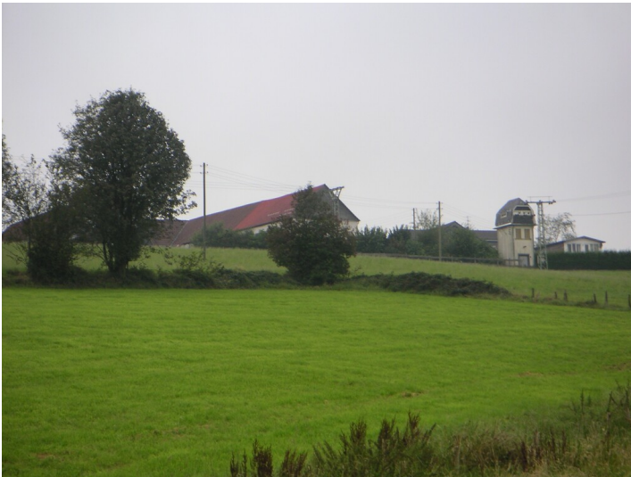
Umspannhaus in Herweg (2007) Fotograf/Urheber: Beate Lange
