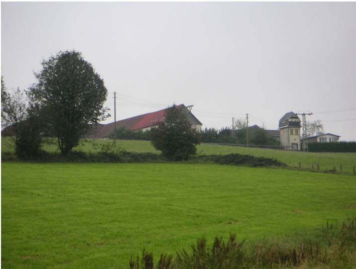
Umspannhaus in Herweg (2007) Fotograf/Urheber: Beate Lange
