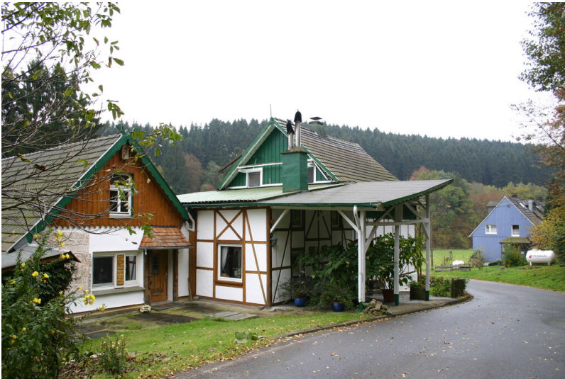
Blick auf die Anlage der Purder Mühle (2008) Fotograf/Urheber: Nicole Fischer
