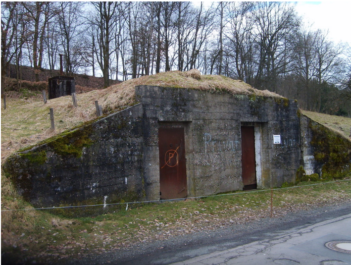
Werkschutzbunker Ommer&Gebcke in Wipperfließ (2009) Fotograf/Urheber: Kleefeld, Klaus-Dieter
