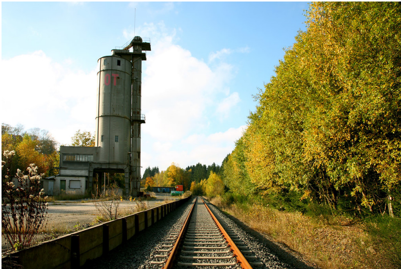
Ehemaliger Güterbahnhof Holzzipper mit Speichergebäude und Gleisen der Bahnlinie Gummersbach - Marienheide - Meinerzhagen (2008) Fotograf/Urheber: Giesen, Ulla Anne
