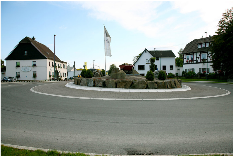
Verkehrsknotenpunkt an der Alten Bergischen Eisenstraße mit den ehemaligen Raststätten für Fuhrleute und der evangelischen Schule in Marienheide-Rodt (2008) Fotograf/Urheber: Ulla Anne Giesen
