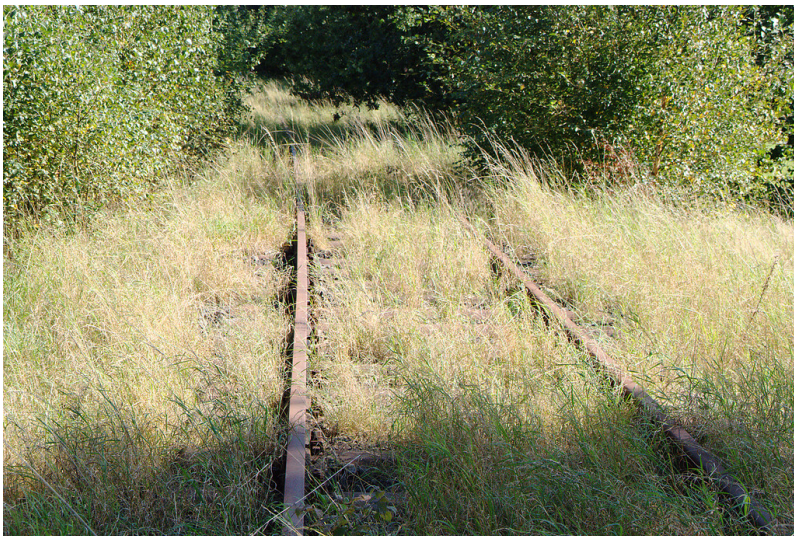
Trasse der Bahnlinie Wipperfürth - Lennep bei Busenbach (2007) Fotograf/Urheber: Attermeyer, Adolf
