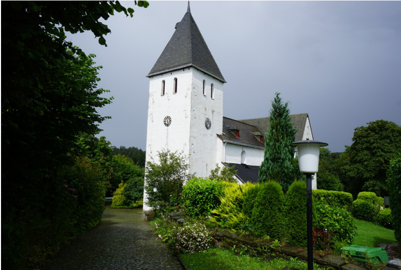
Kirche von Müllenbach (2024) Fotograf/Urheber: Martina Gelhar
