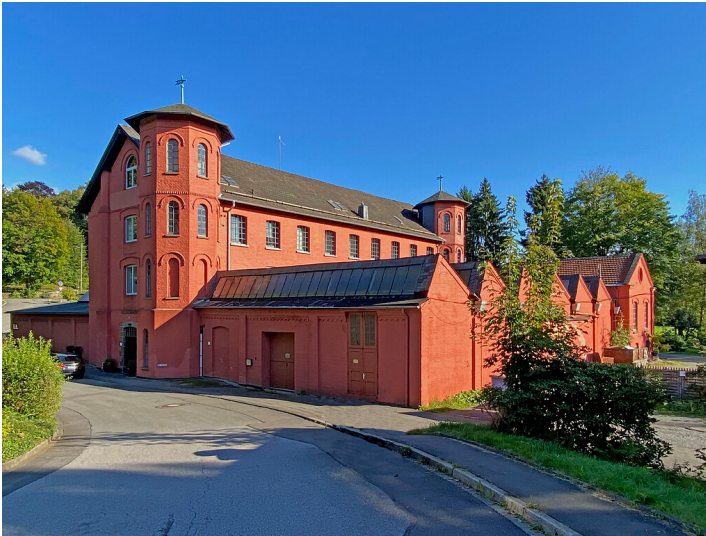
Die ehemalige Tuchfabrik Arnold Hueck & Cie in Hückeswagen (2021) Fotograf/Urheber: Dietfried Auras
