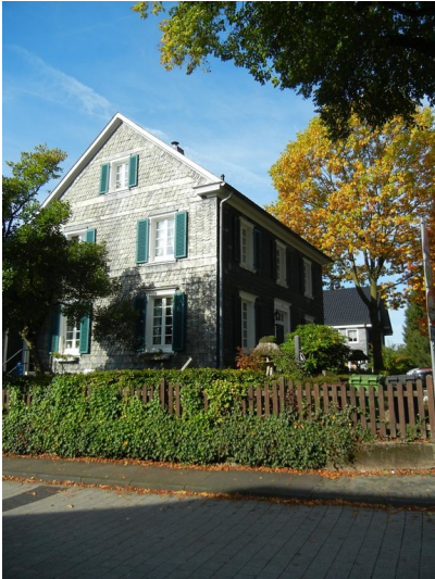
Wohnhaus in Thier (2013)
