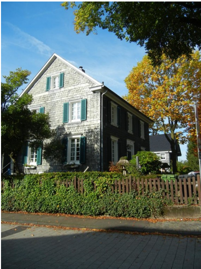
Wohnhaus in Thier (2013)
